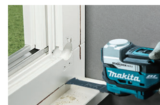
4 窓枠の取り外し
