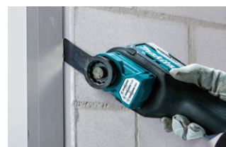
7 弾性シーリング除去作業
