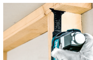
2 外枠調整の面一切断
