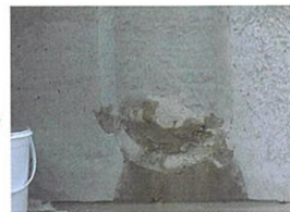
④止水完了確認後、手を離す。 余分な材料を除去し、作業完了。
