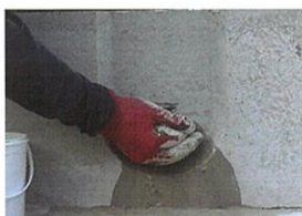
②漏水箇所へ狙いを定め 「即トマー」を強く押し付ける。
