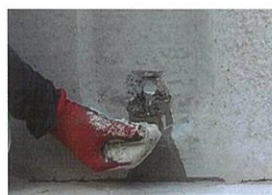
①ボトルから「即トマー(粉体)」を 手に取り、漏水箇所へ。
